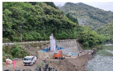
4月進捗 軽量盛土工 基礎ブロック設置
