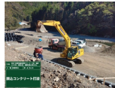
護岸コンクリートブロック施工
