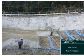
3月進捗 2次施工 モルタル吹付
