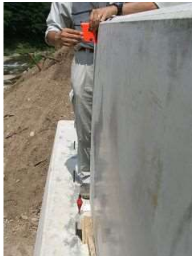
写真-29 (例) 下げ振りによる鉛直度の確認
