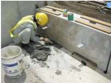
写真-11 モルタル充填作業状況
