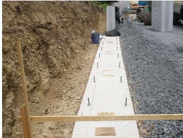
写真-8 不陸調整用スペーサー設置状況
