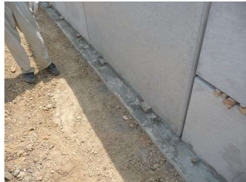
写真-12 モルタル充填完了状況
