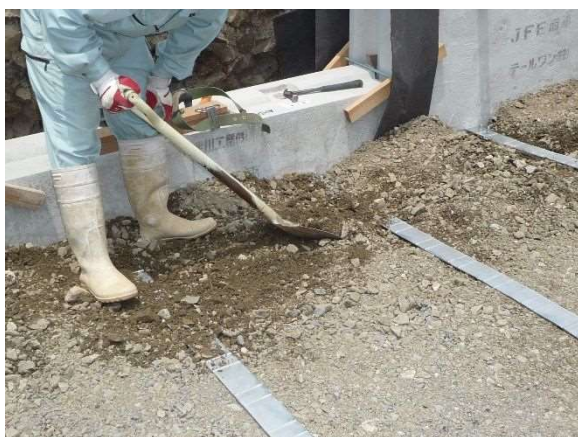
写真－27 ストリップ取付け部の施工
