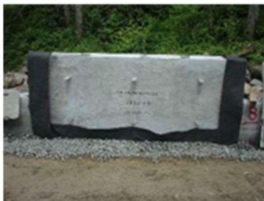
写真－21 透水防砂材設置
