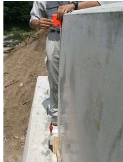
写真-10 下げ振りによる傾斜度確認
