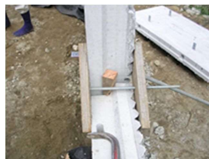
写真-6 一般用くさび設置
