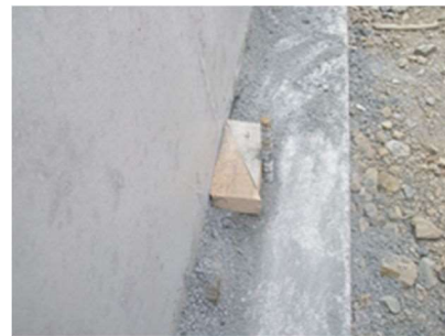
写真-7 最下段用くさび設置状況
