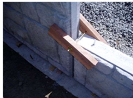
写真-5 クランプ設置状況
