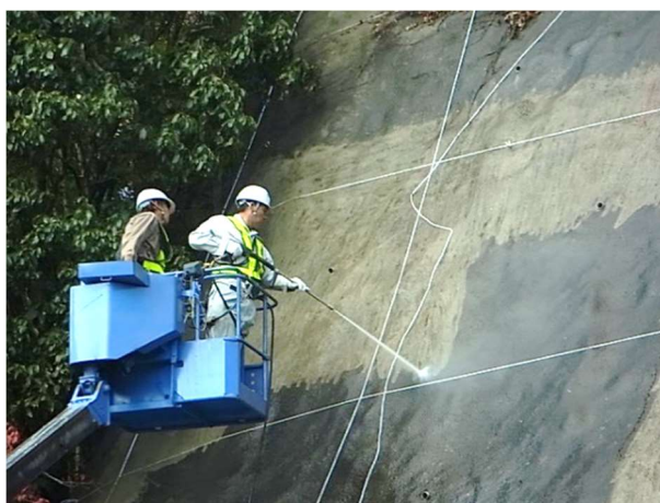
写真-4.2.1 高水圧洗浄工状況
