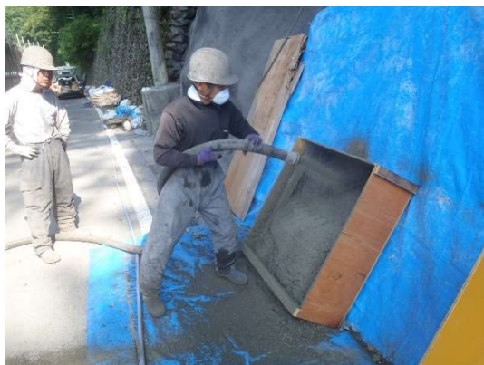
写真-1 供試体作成状況
