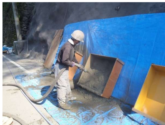
写真-2 供試体作成状況
