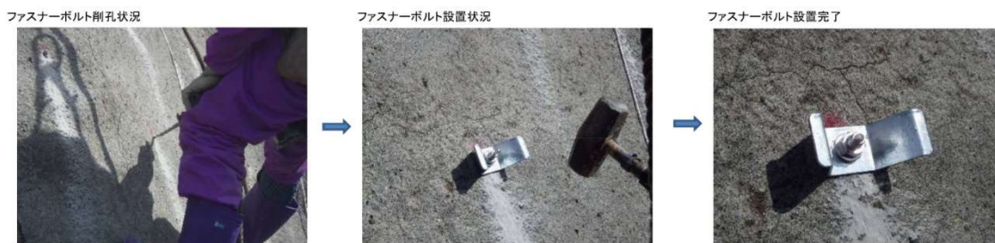
写真-4.2.4 ファスナーボルト設置手順
