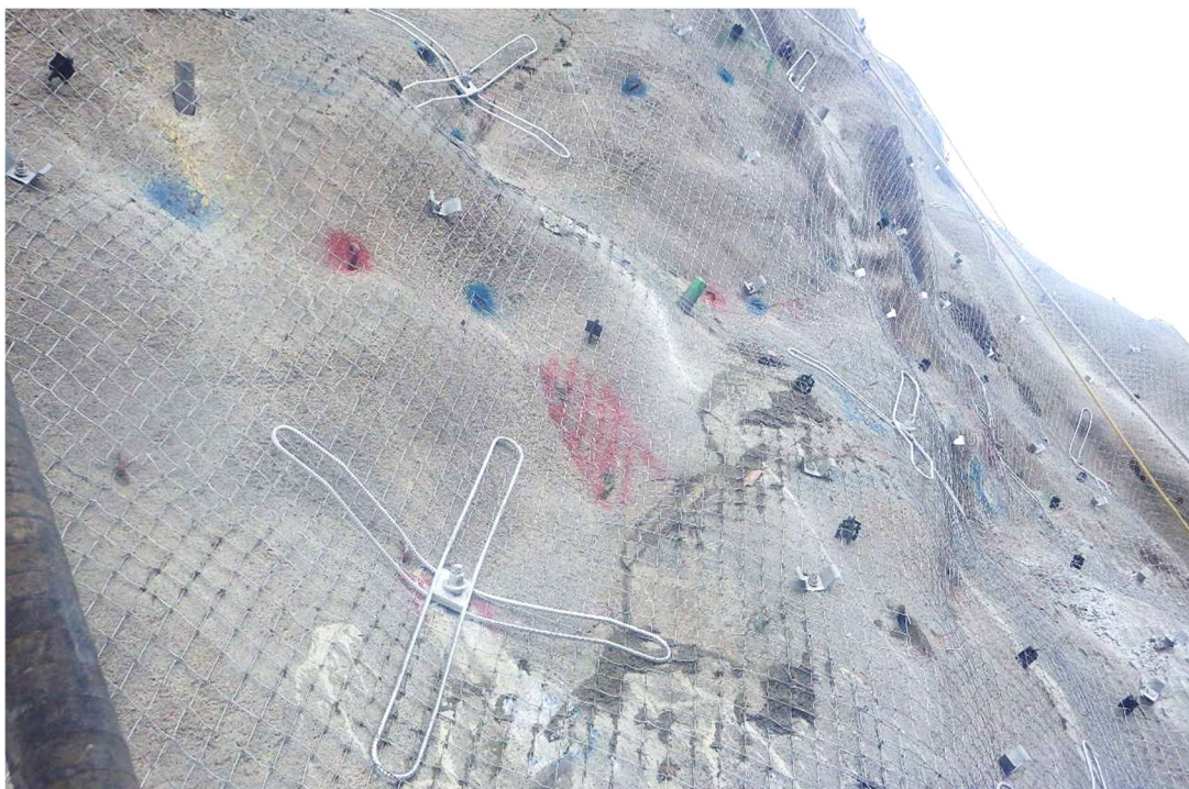
写真-4.2.3 凹凸部設置例
